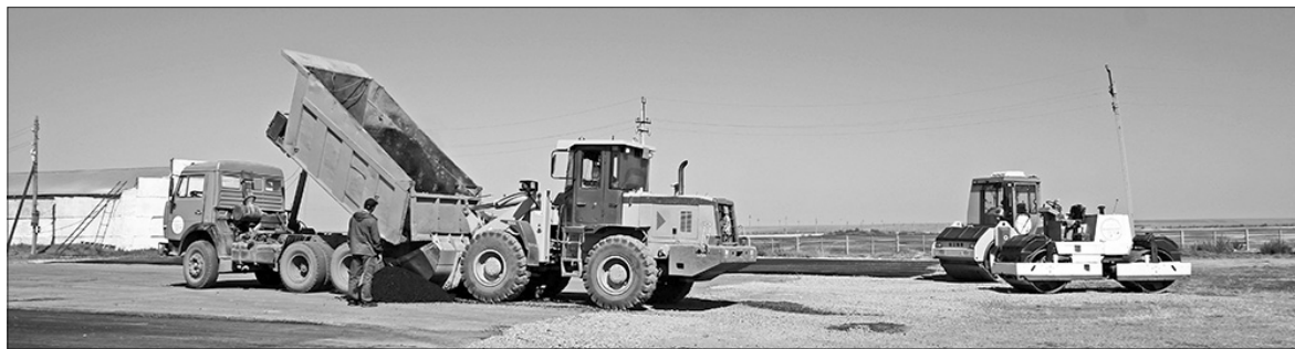
Рабочий момент ремонта территории складских помещений
